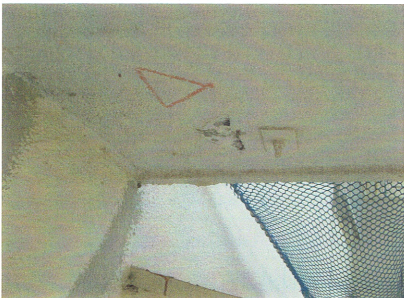
室外機天吊りボルト引張 強度確認
