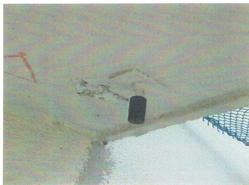
室外機天吊りボルト引張 強度確認
