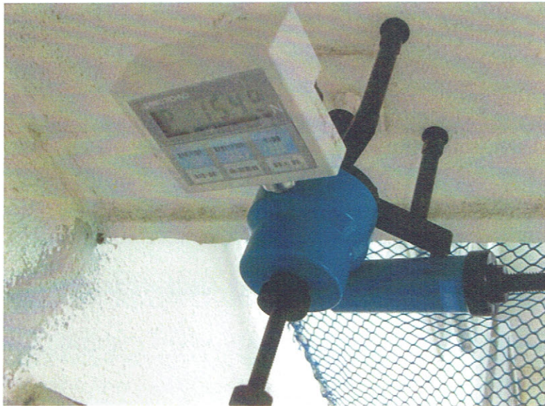
室外機天吊りボルト引張 強度確認
