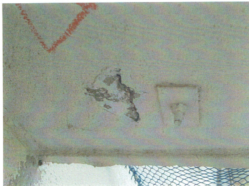
室外機天吊りボルト引張 強度確認
