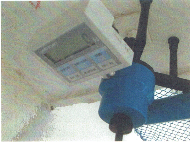
室外機天吊りボルト引張 強度確認
