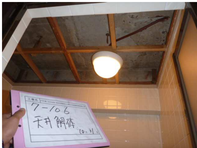
浴室天井解体状況
