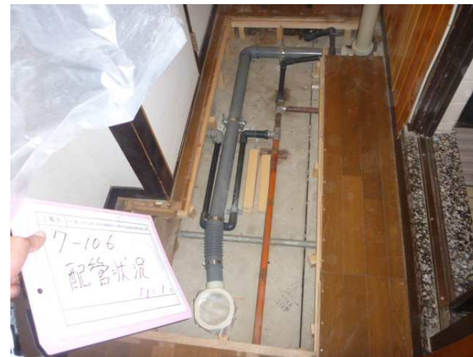
洗濯パン排水管施工状況(2)
