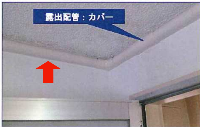
廊下・洗面所の天井部
