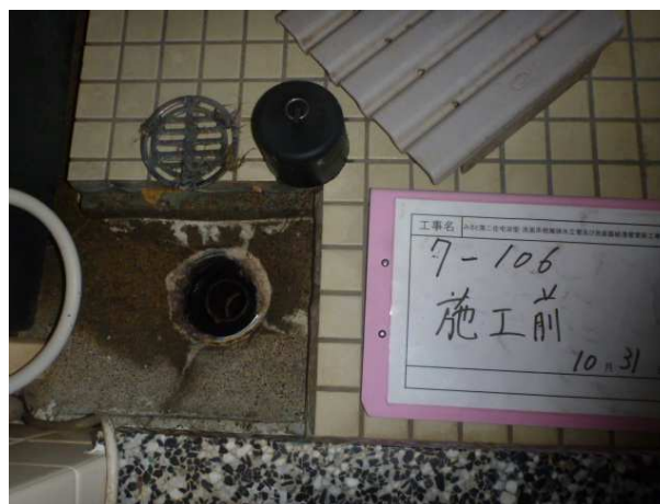
浴室排水口状況
