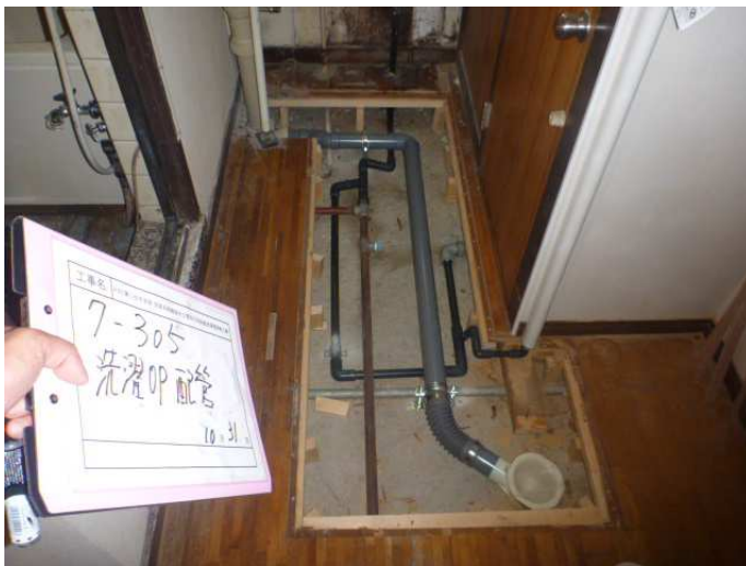
洗濯パン排水管施工状況(1)
