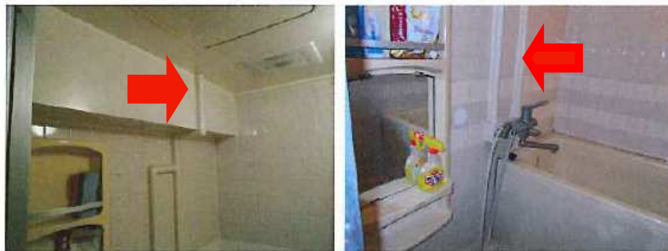
浴室：水栓廻り
